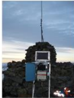
Montering av repeater
